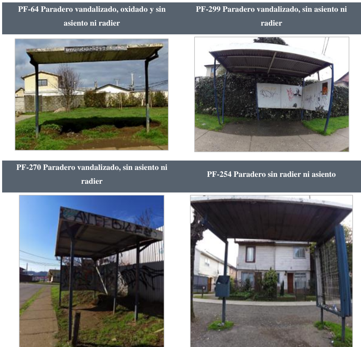
Figura 5.13: Ejemplo de paraderos diagnosticados como “reparación mayor”
